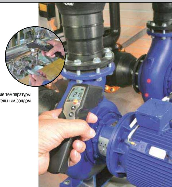
Измерение температуры дополнительным зондом
